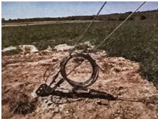
**Figure 1 : Ancrage des haubans**
